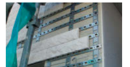
NC新シュタルネット工法
