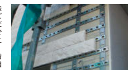
NC新シュタルネット工法
